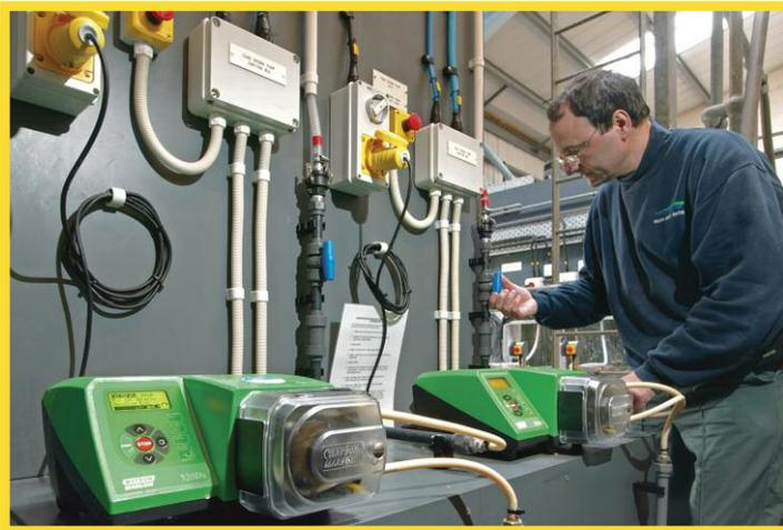
*Pumpen der Serie 500 lösten problematische Membranpumpen beim Dosieren von Gerinnungsmitteln ab*
