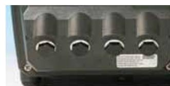
Il numero delle guarnizioni necessarie dipende dal numero di cavi di collegamento necessari e dalle decisioni dell'installatore. Di norma, sono fornite in dotazione con la pompa quattro guarnizioni M16 per cavi.
