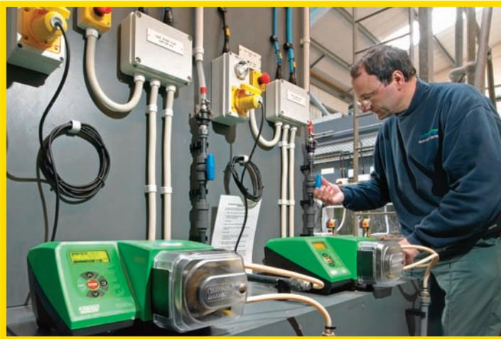
*As bombas da série 500 substituíram bombas de diafragma problemáticas na dosagem de coagulante*
